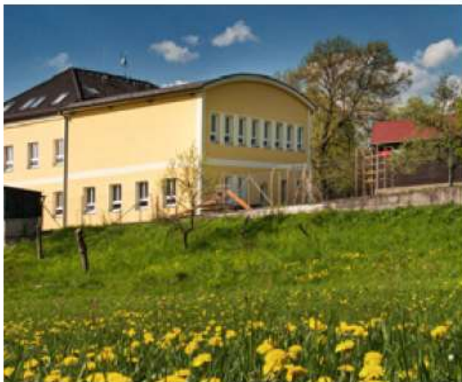
Nová tělocvična, květen 2013 (foto J. Těr)
