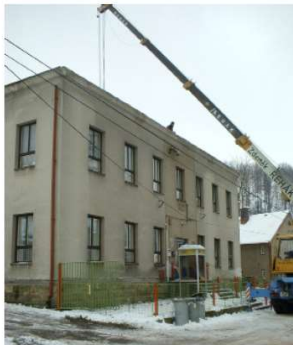
Oprava střechy školy, prosinec 2005 (archiv ZŠ a MŠ Suchý Důl)
