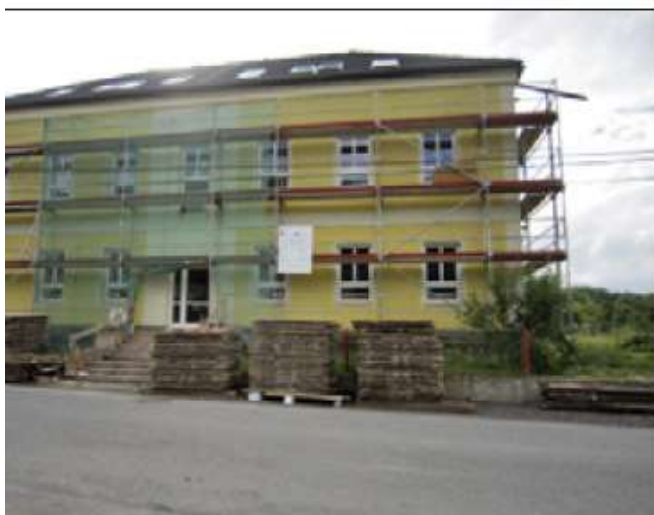
Zateplení a nová fasáda, červen 2010 (archiv ZŠ a MŠ Suchý Důl)
