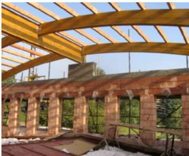
Budování nové střechy v tělocvičně, podzim 2009 (archiv ZŠ a MŠ Suchý Důl)
